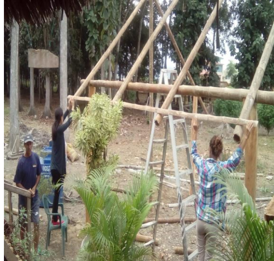
Colocación de las latillas en el caballete
