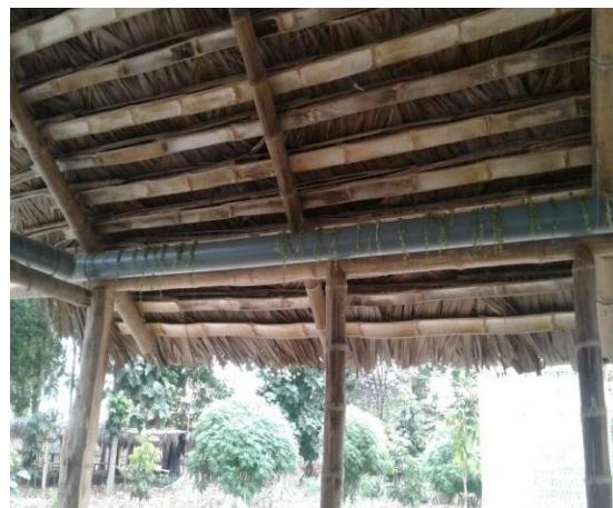
La colocación de los respectivos tubos en la parte exterior e interior
