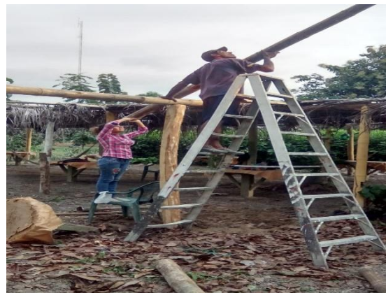
Levantamiento de las cañas
