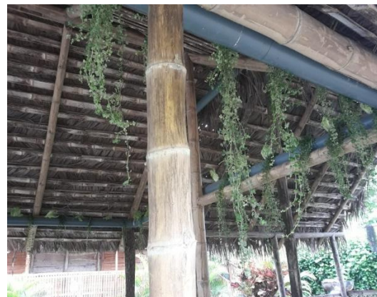
Colocación de las cortinas
