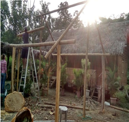
Colocación de las cañas para el caballete
