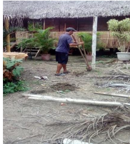
Anexo 1.A. Reconocimiento del área de estudio y elaboración de los huecos para la colocación de los horcones.
