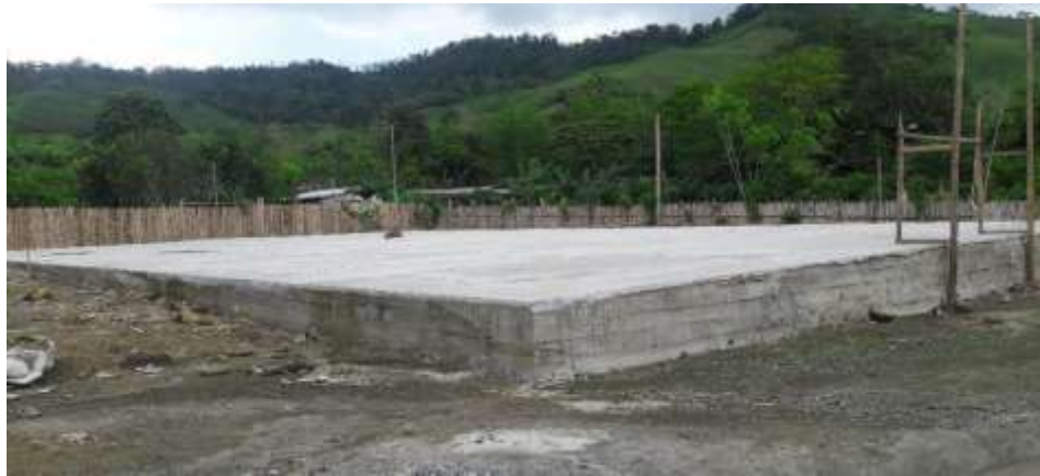
Foto 6. Cancha deportiva ubicada en el sector Japón
