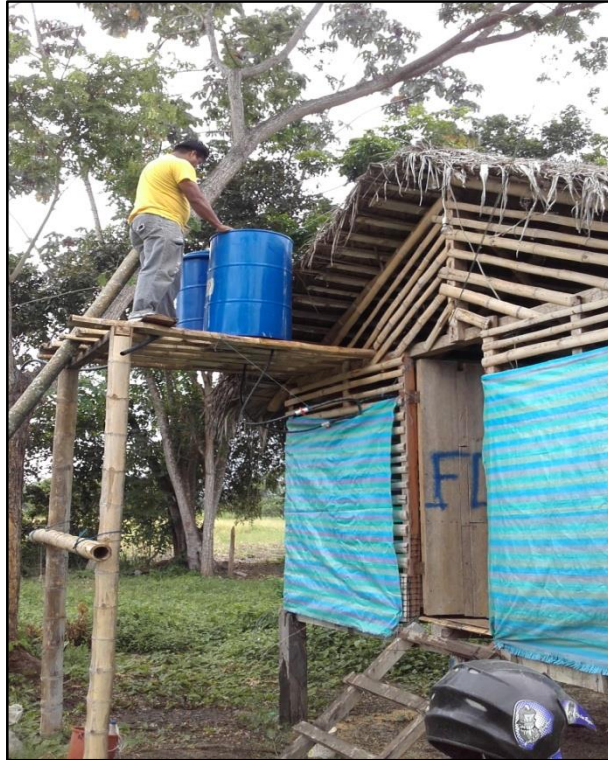
ANEXO 1. Acondicionamiento del galpón.
