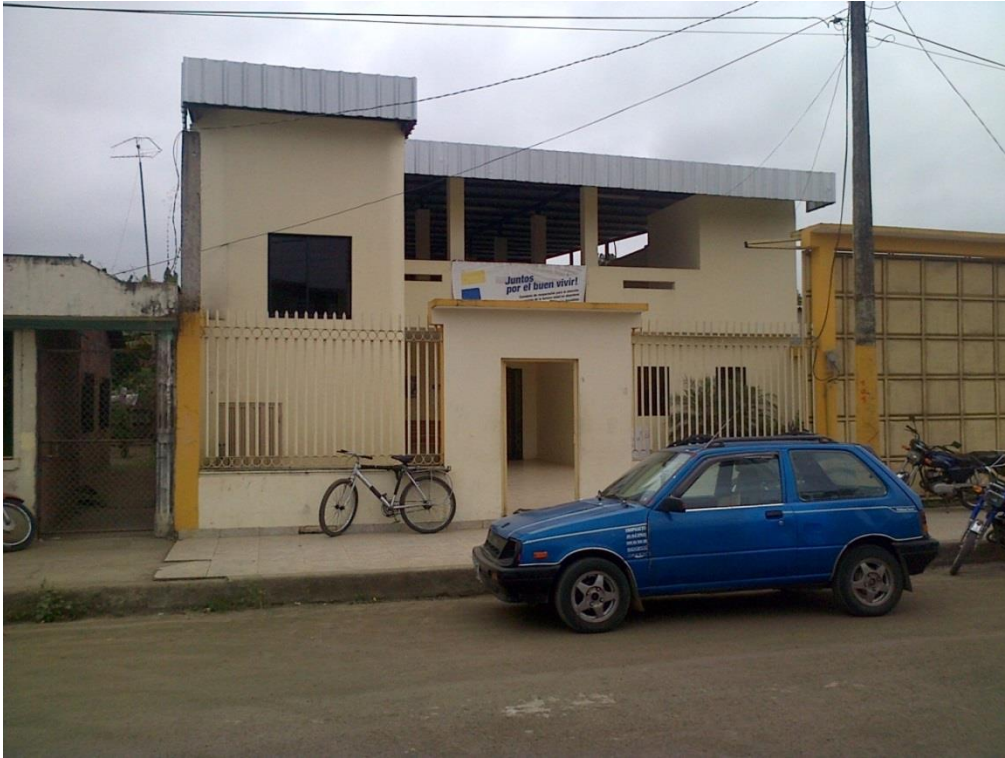
Anexo 6-A. Fachada frontal del Edificio del Patronato Municipal de Amparo Social
