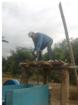
Construcción del diseño acuaponico
