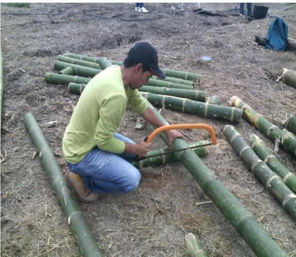
Corte de cañas para el levantamiento de las cámaras.
