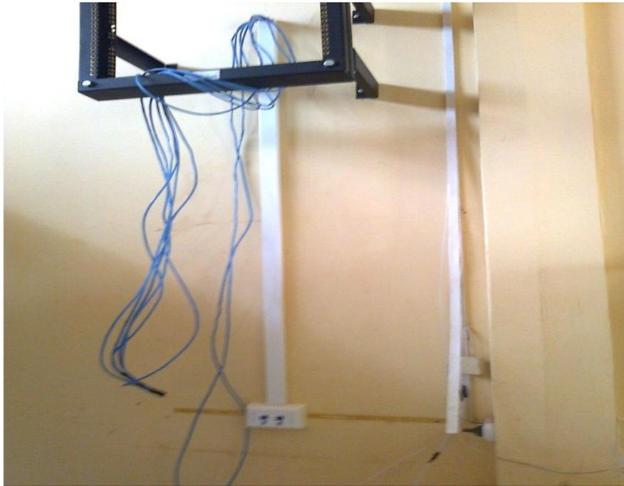
Foto 1. Instalación del pachpanel con salida a los diferentes bloques del área administrativa
