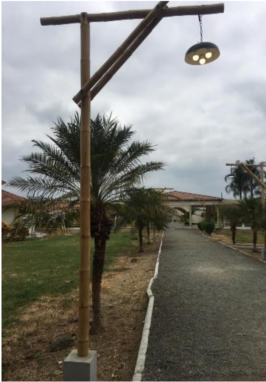
Anexo 16. Luminarias vistas de día
