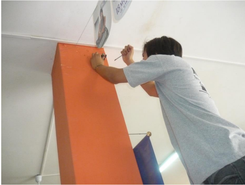
Foto 5 Durante la instalación de una de las cámaras, en el área principal
