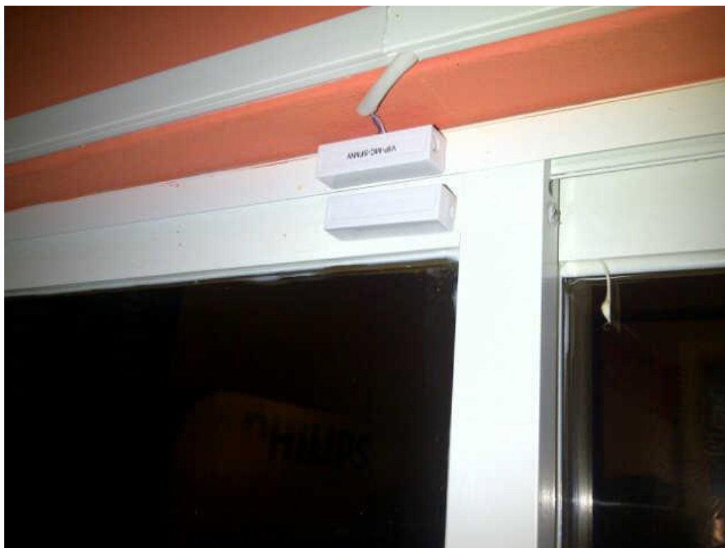
Foto 11 Contactos magnéticos en la puerta de la oficina
