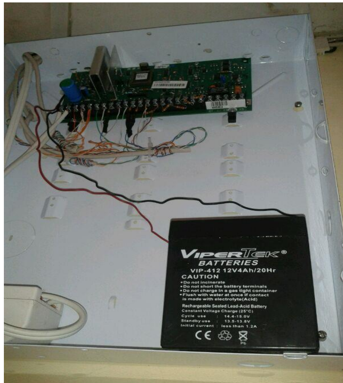
Foto 7 Instalación de la alarma principal
