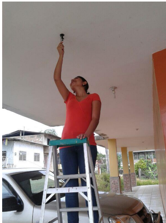
Foto 8 Durante de la instalación de los equipos en la parte exterior del almacén
