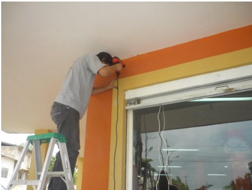
Foto 6 Durante de la instalación de una de las cámaras en la parte exterior del almacén
