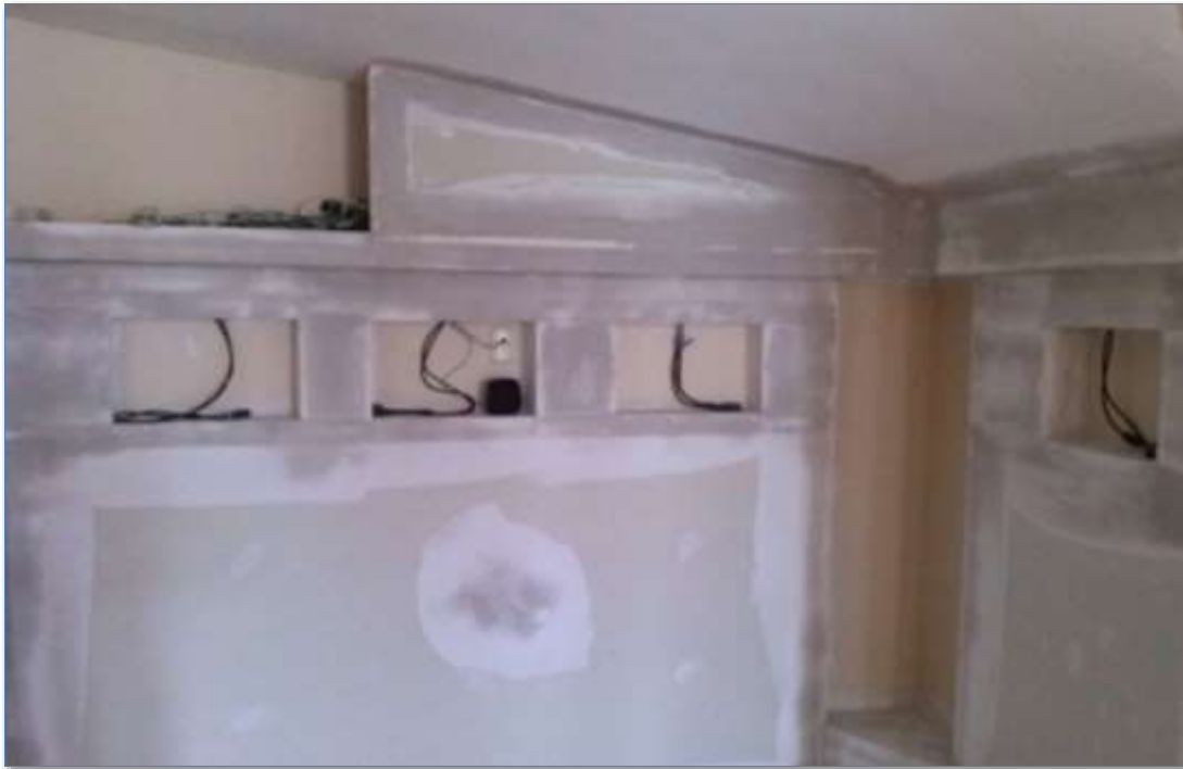
Figura 4.10. Cerramiento de la Galería Fuente: Autores
