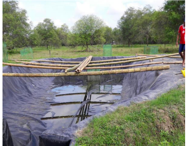
Anexo 5. Preparando terreno para las piscinas.
