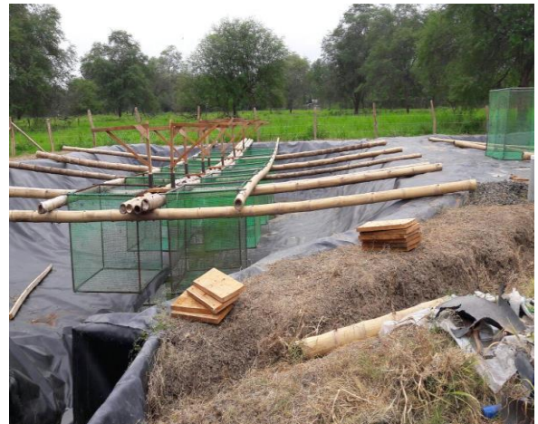
Anexo 5. Reconstrucción de las piscinas.
