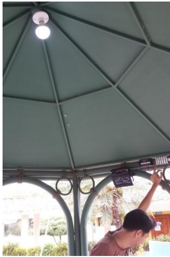
Anexo 2. E. Prueba de funcionamiento mediante luz piloto.
