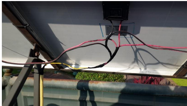
Anexo 2. C. Construcción de los terminales de carga
