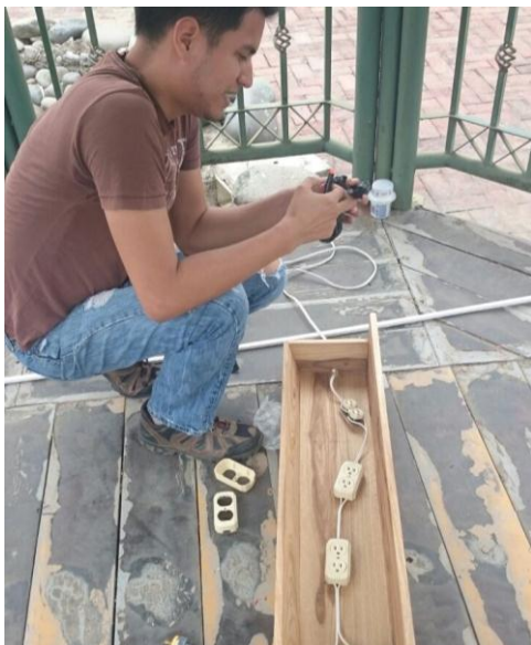
Anexo 2. C. Construcción de los terminales de carga
