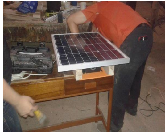
Anexo 10.12. Instalación del sistema fotovoltaico
