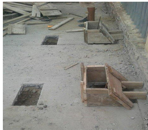
Anexo 10.8. Base de la estructura
