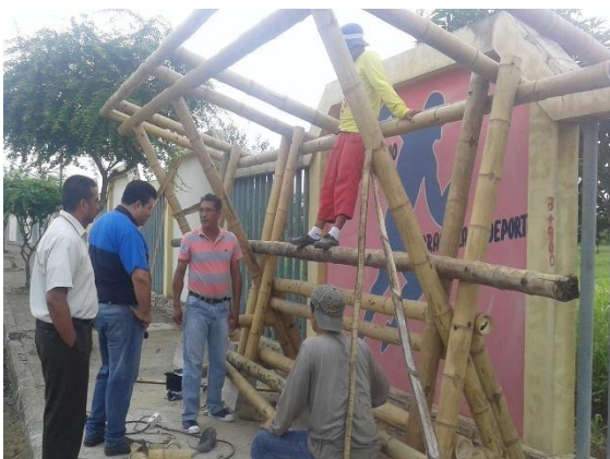
Anexo 10.9. Construcción de la estructura
