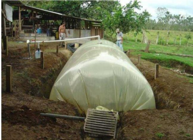
**Figura 2.4:** Biodigestor tipo plástico de flujo continuo tipo CIPAV chino.
