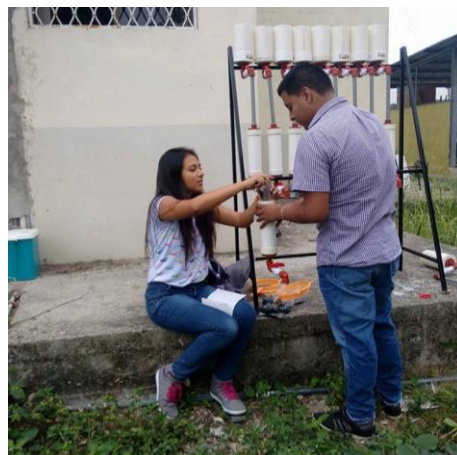
Anexo 4-D. Instalación de los filtros
