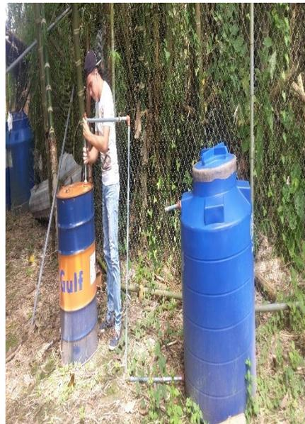
**Anexo 1. D. Implementación de tuberías del biodigestor hacia el gasificador**
