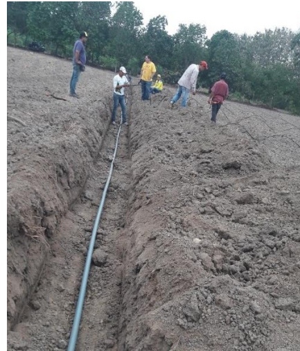
Instalación del sistema de riego.
