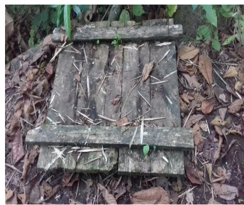
Foto 4.13. Reservorio de agua de la comunidad de Matapalo
