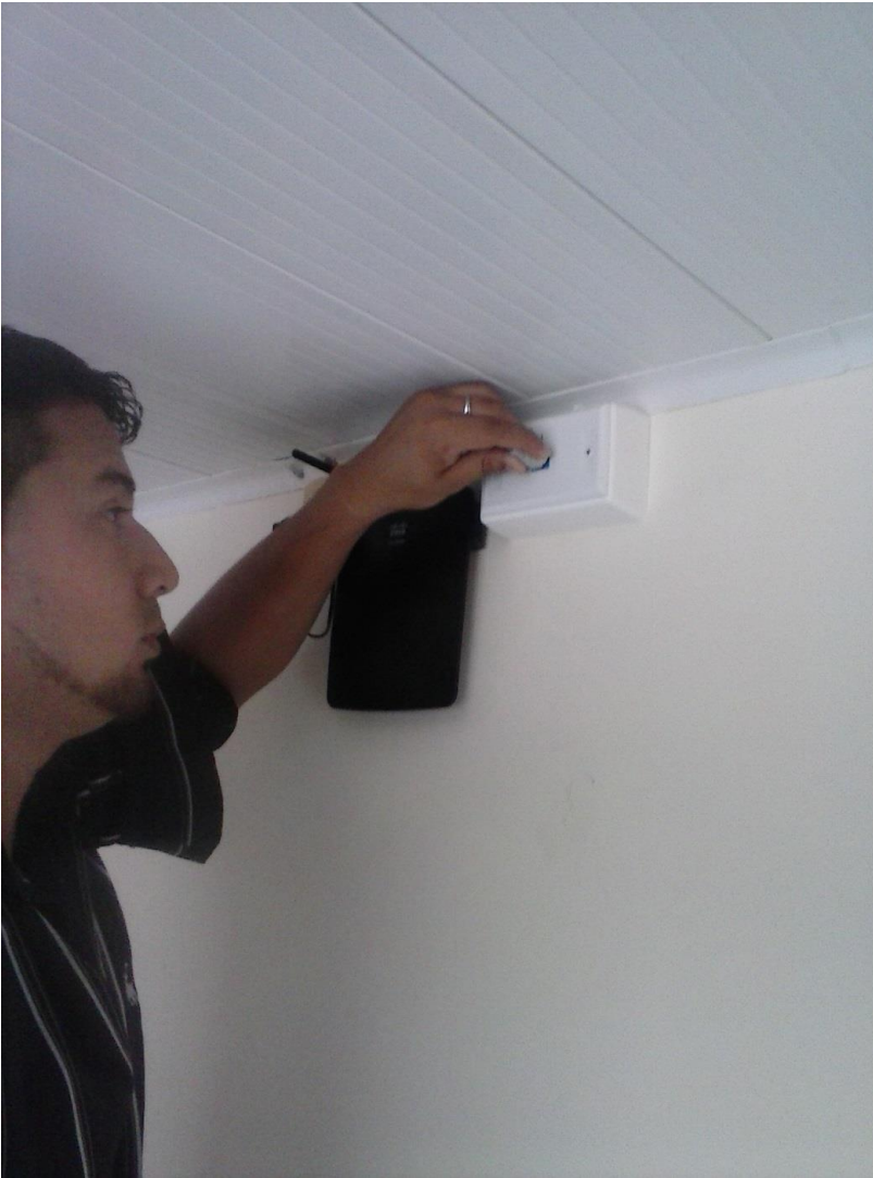
Foto 9 El autor instalando uno de los Access Point para internet vía WIFI
