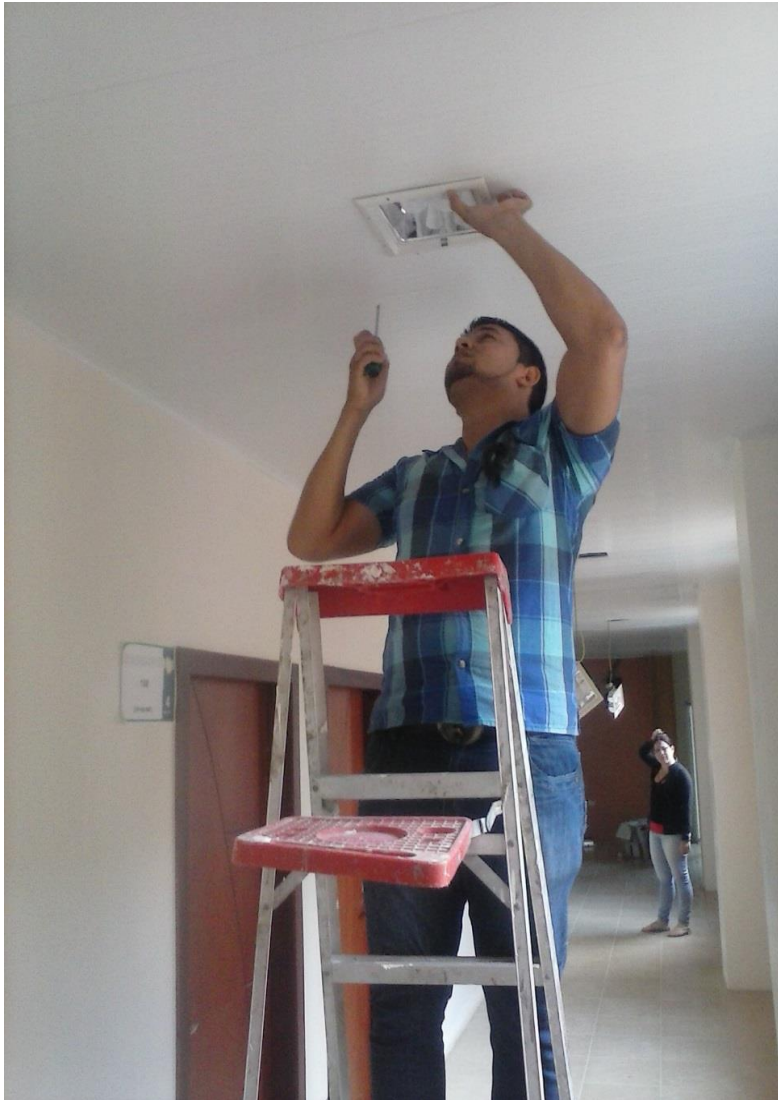
Foto 3 El autor realizando el tendido del cable en las habitaciones del Hotel
