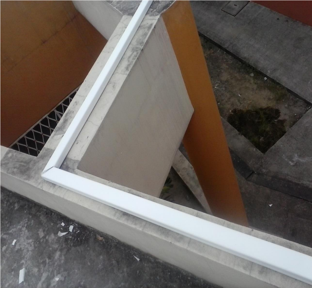
Foto 5 Canaletas ya instaladas en el tumbado del Hotel
