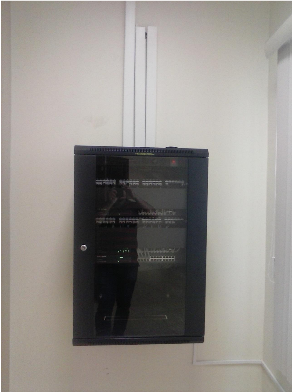
Foto 20 Equipo principal ya instalado
