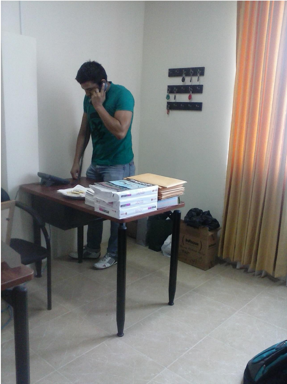
Foto 16 El autor realizando pruebas y comprobando el correcto funcionamiento de los Teléfonos
