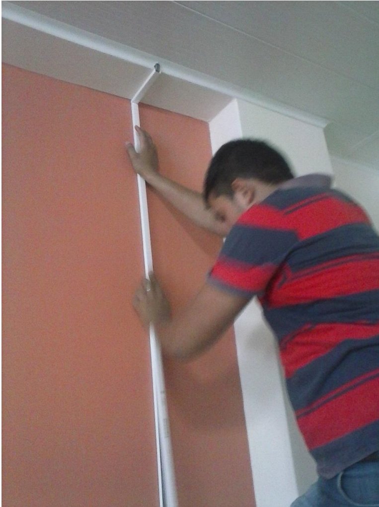
Foto 4 El autor colocando las canaletas del sistema de comunicación
