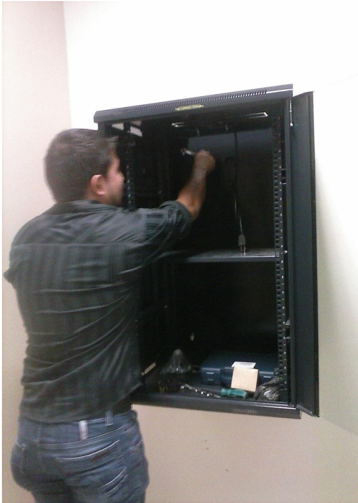
Foto 2. El autor instalando el rack de pared, donde se ubicó el servidor y demás equipos.
