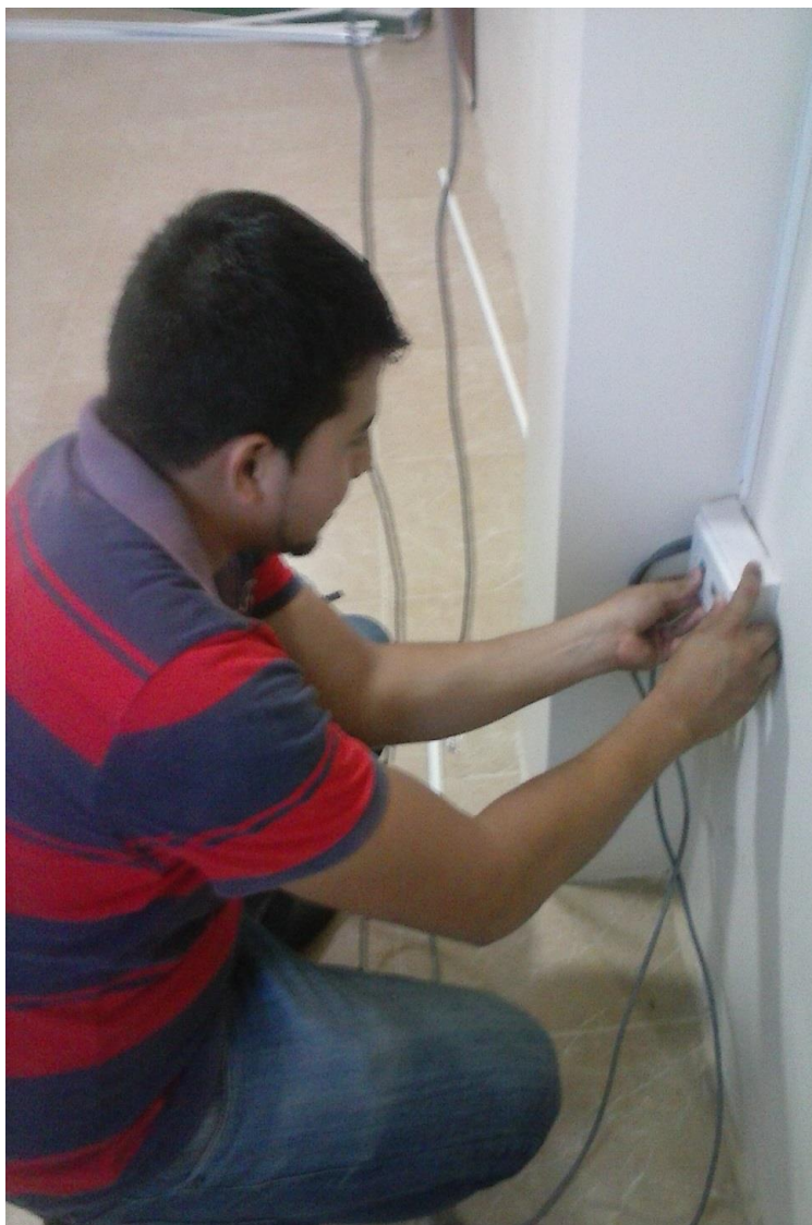
Foto 6 El autor instalando las cajas sobre puesta y faceplate de 2 tomas.
