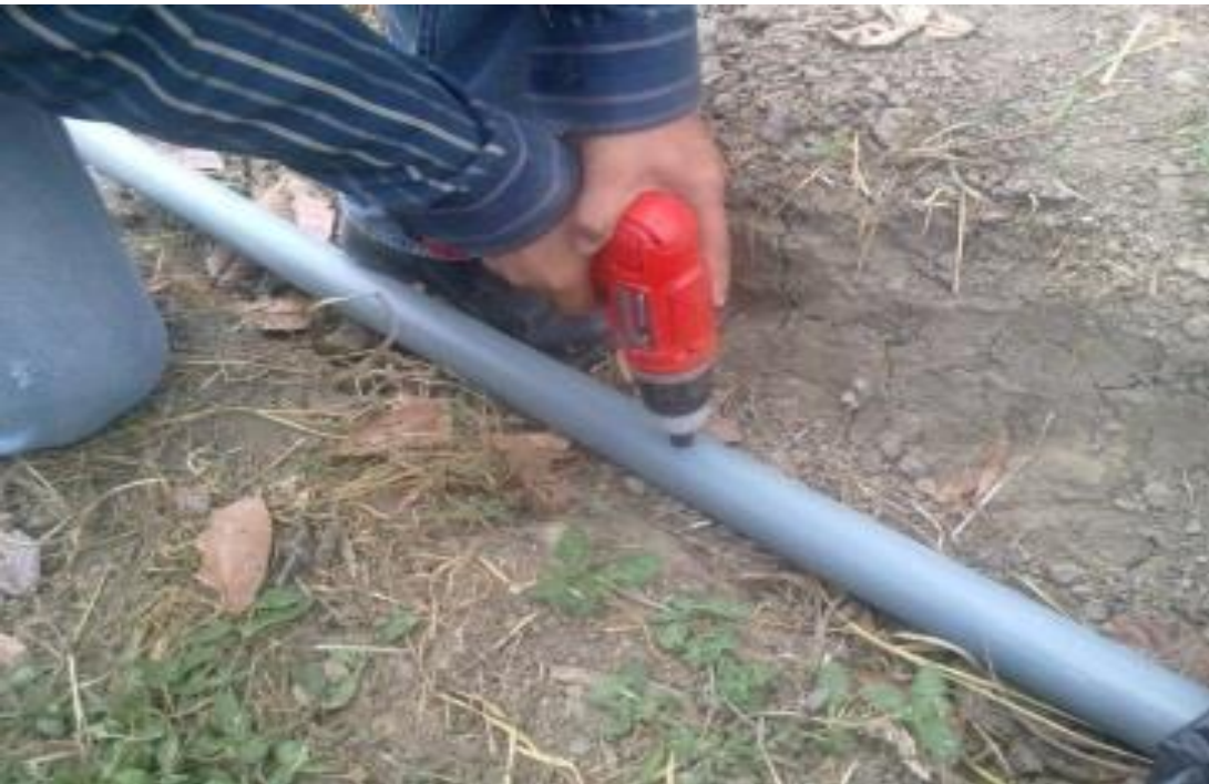
Foto. 4 Perforación de tuberías
