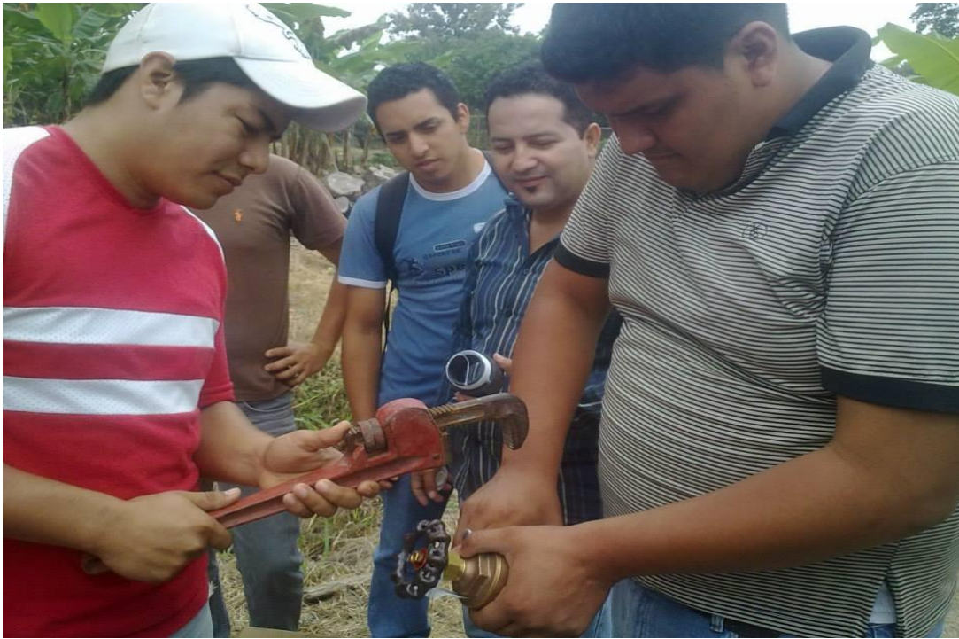
Foto. 3 Instalación de accesorios
