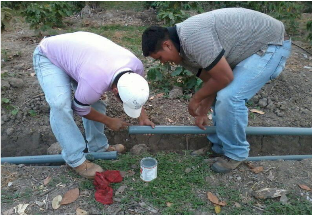
Foto. 2 Instalación de tuberías
