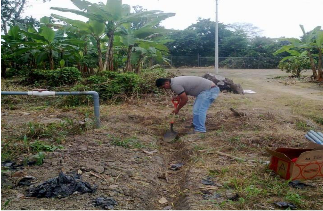
Foto.1 Zanjeó del terreno
