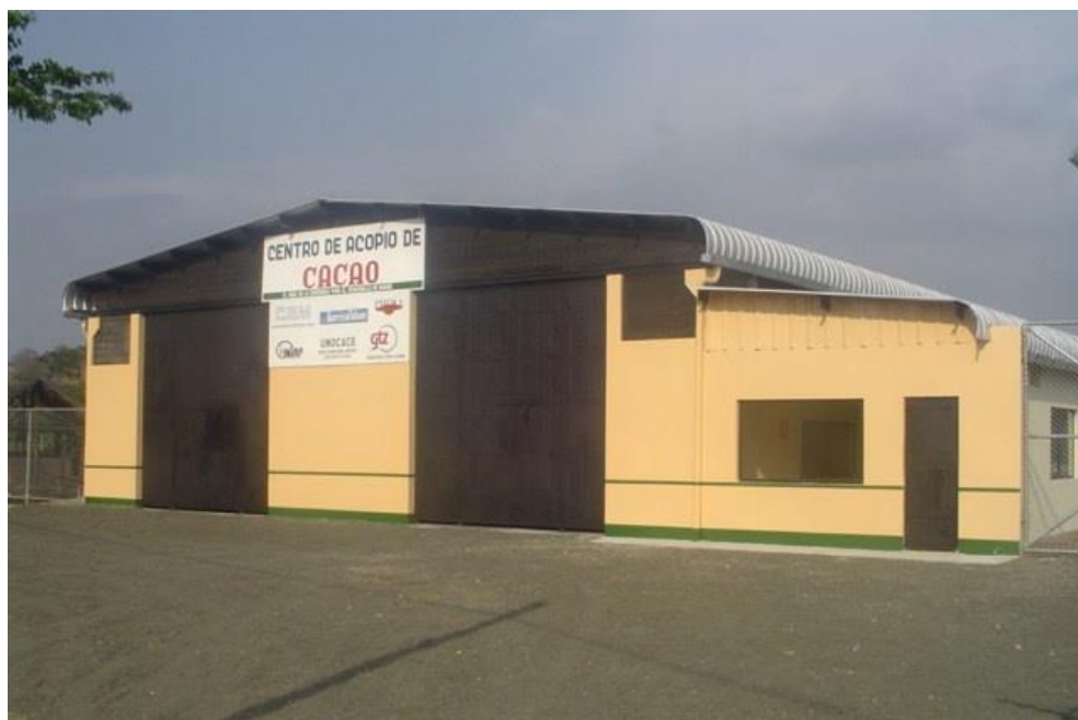
INSTALACIONES DE LA ASOCIACIÓN FORTALEZA DEL VALLE
