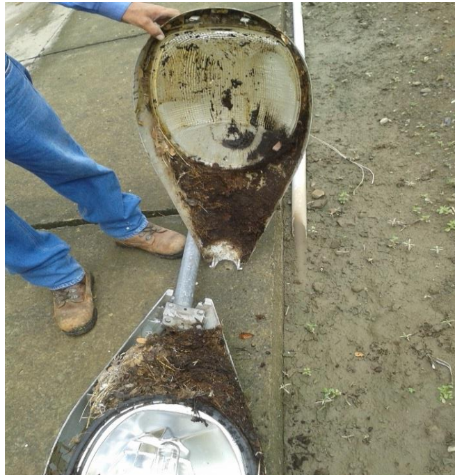
Foto. 3 Limpieza de luminaria del campo politécnico
