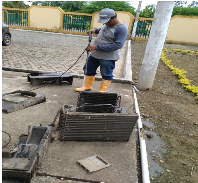
Foto. 7. Limpieza de aire acondicionado
