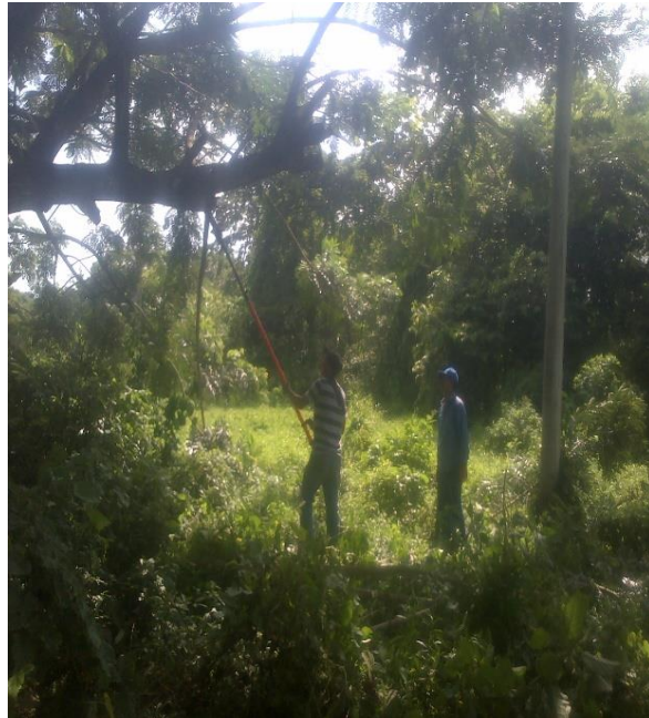
Foto. 5. Desbroce de arboles
