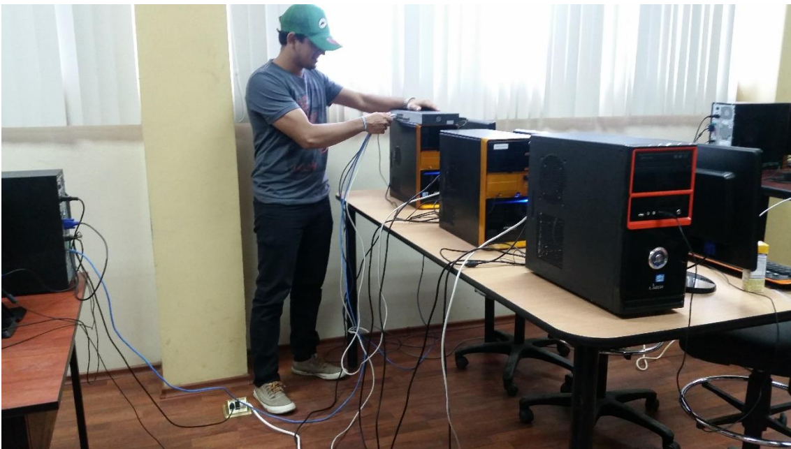
Imagen A.3. 2. Uno de los autores conectando el cable de red del servidor al switch y de este a las máquinas clientes
