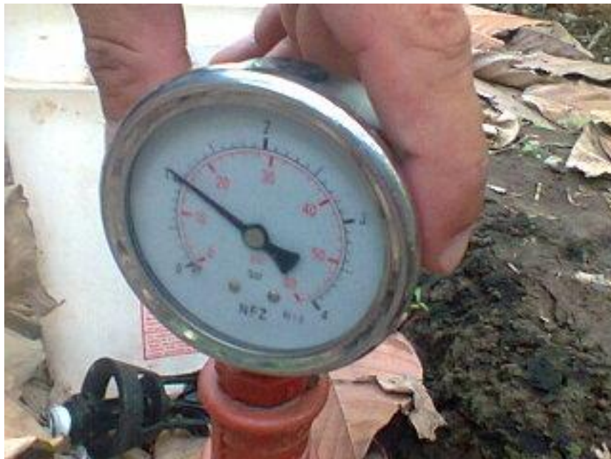
La toma de presión en entrada y salida de los laterales y varios del sistema
