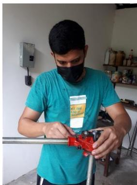
**2-N.** Ajustes del sistema de tuberías.
