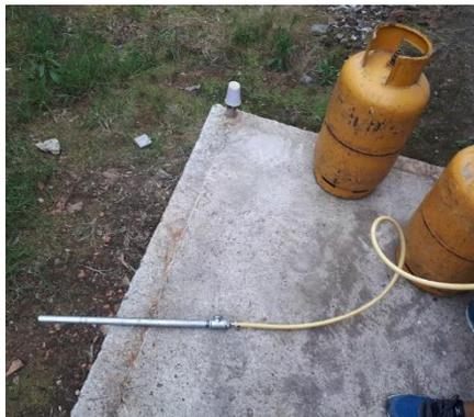
**2-L.** Ajustes del cilindro al sistema
