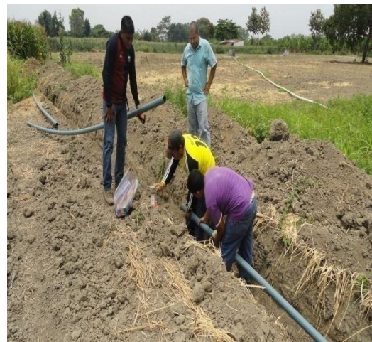
INSTALANDO EL RAMAL DE RIEGO
