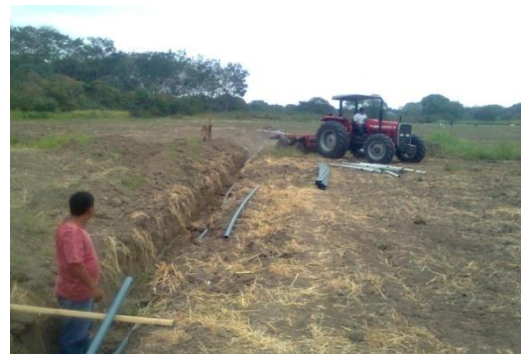
TRAZO DE ZANJA PARA LA SECUNDARIA
