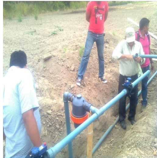
INSTALANDO LA VÁLVULA AQUANET 2
