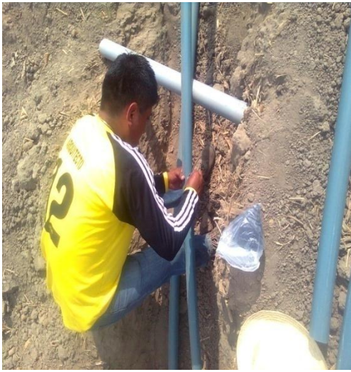
COLOCACIÓN DE CHUPONES
