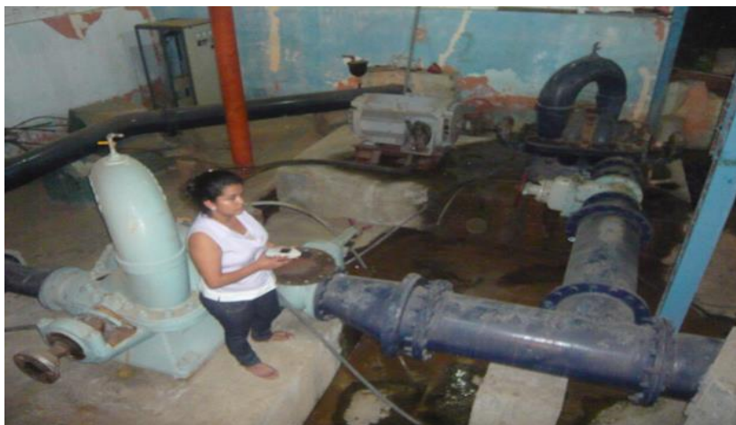
Anexo 5- B; medición de ruido en la estación de bombeo 2
