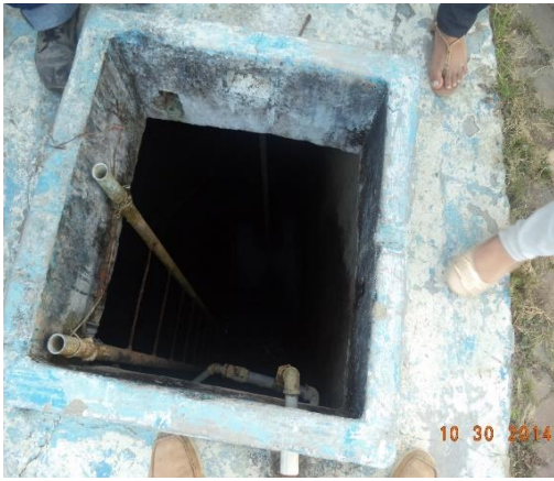
Anexo 11-A. Orificios con escaleras subterráneas sin tapas.
