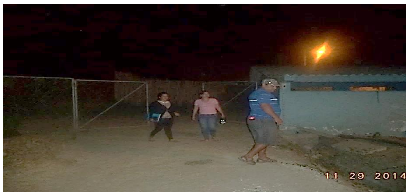
Anexo 7-C; déficit de iluminación en la noche, estación de bombeo 1
