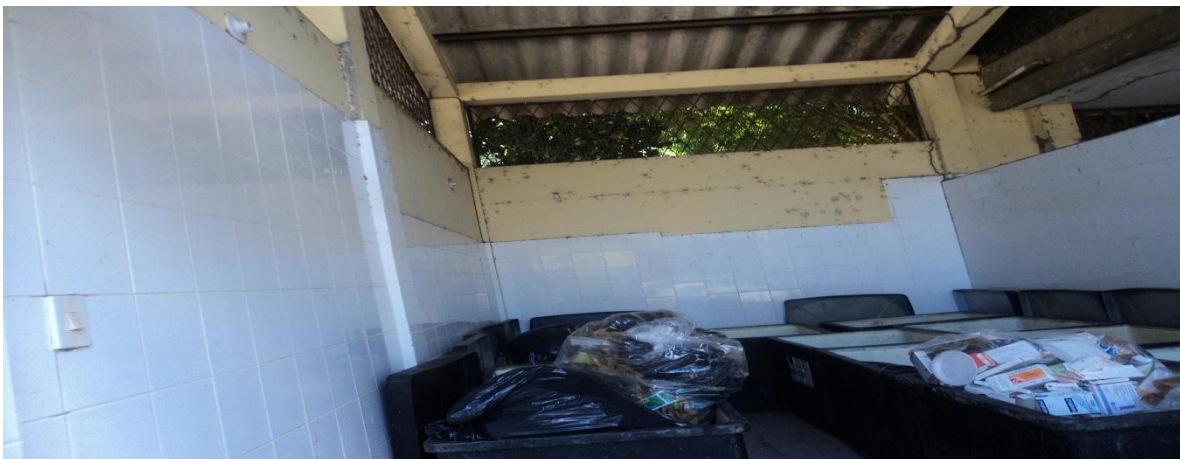
Fotos 6. 9. Almacenamiento final inadecuado
