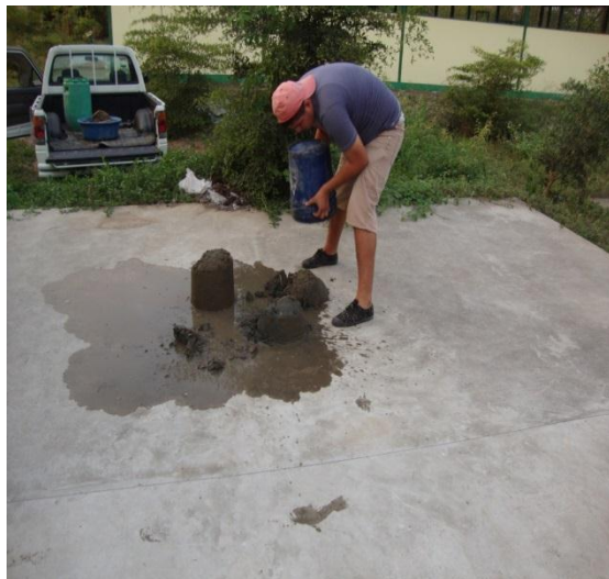
4- C Vaciado de la muestra
