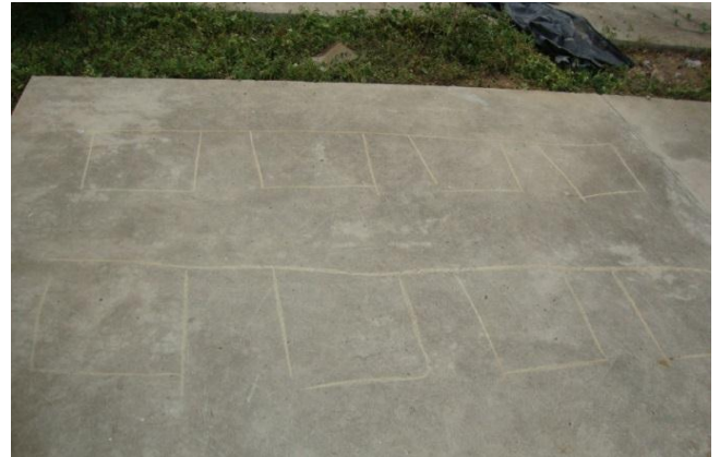
5-B Preparación del terreno
