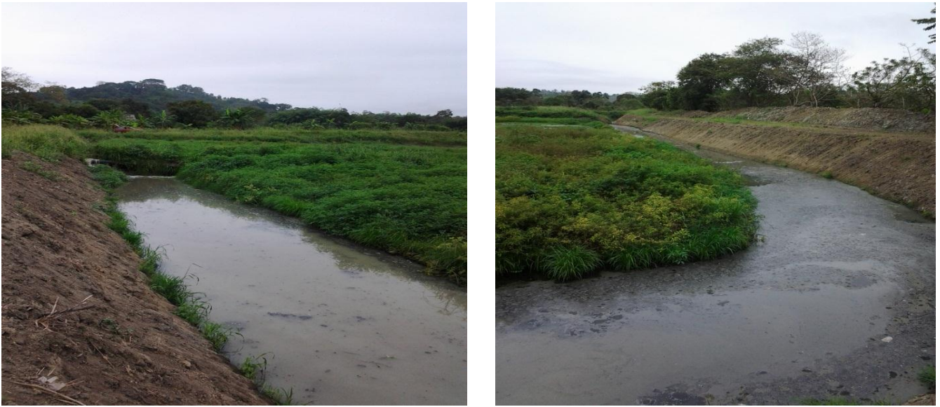
Canal de transporte del agua residual
