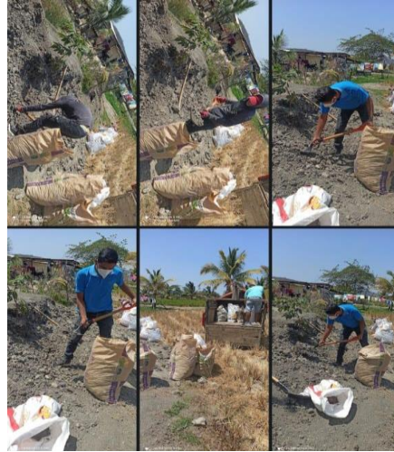
EXTRACCIÓN DEL SUELO
