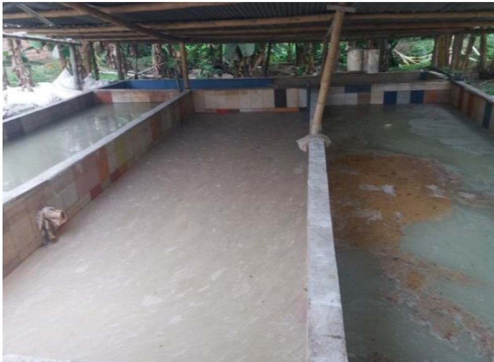
Foto 1. Almacenamiento del agua residual en las almidoneras
