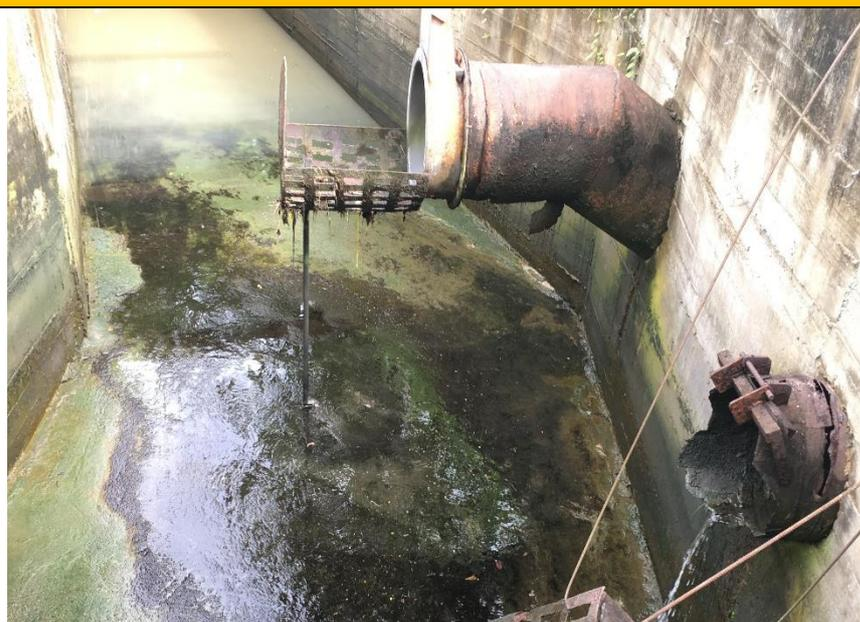
El pasivo corresponde a una tubería de salida de sistema de producción de la bananera de la parroquia La Estancilla, al ser de producción orgánica el fluido liberado posee una alta carga orgánica
