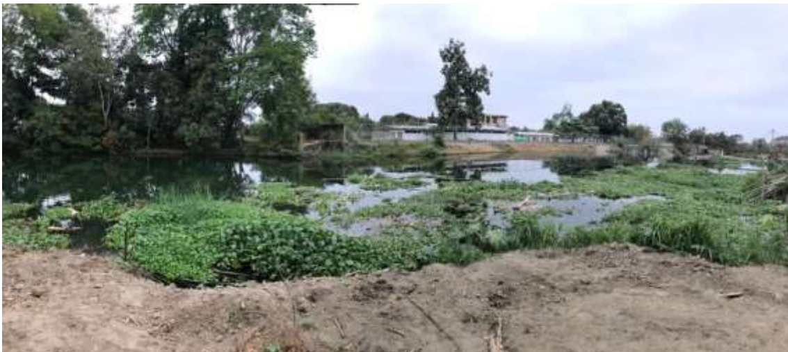
Anexo 14. Lechuguines en embalsamiento de la planta de tratamiento “La Estancilla”
