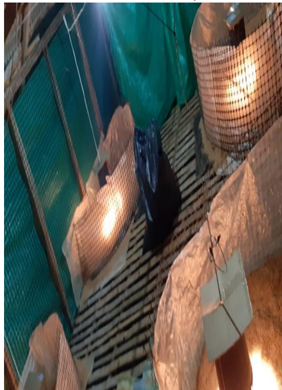
ANEXO Nº 6: Instalación de bebederos comederos, y luz.
