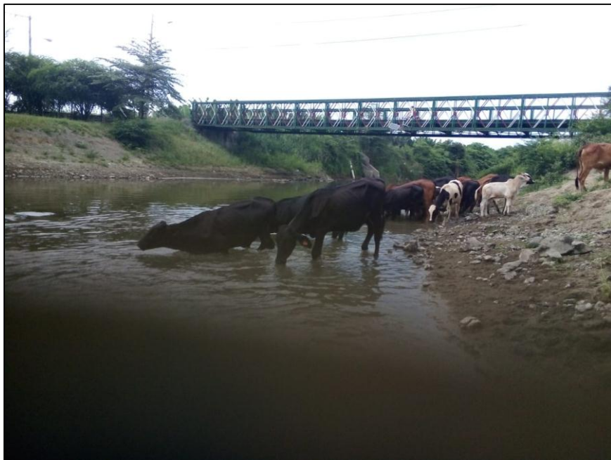
Foto 6. Sector 3 – Puente El Limón
