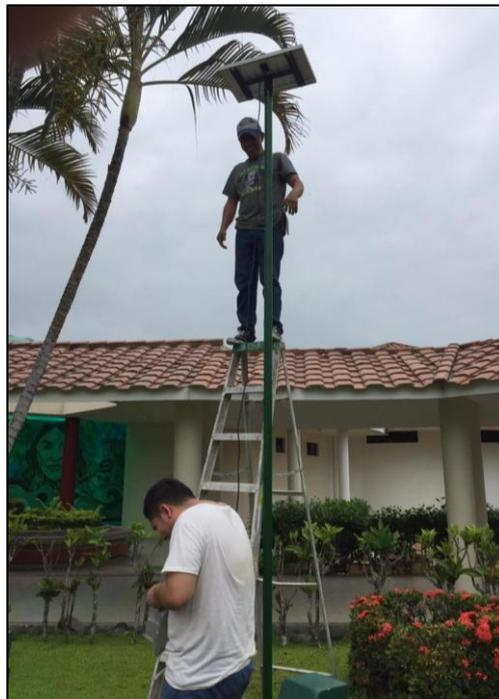
**Foto 2.** Instalación de la base del panel
