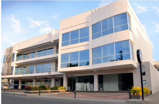
FIGURA 7 Edificio Plaza Constitución
