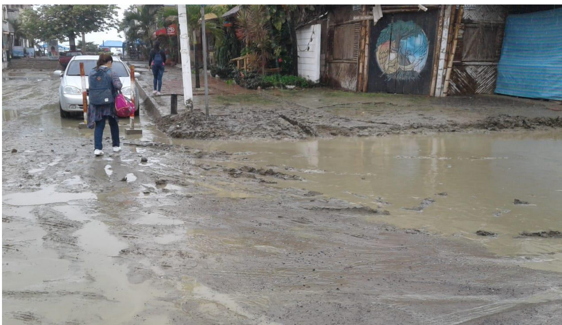
Anexo 9. Mal estado de calles y aceras.
