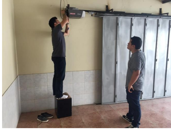
Figura 3. 18 Instalación de relé
