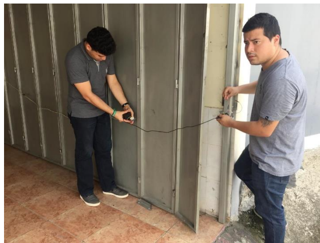
Figura 3. 19 Instalación de detector de obstáculos
