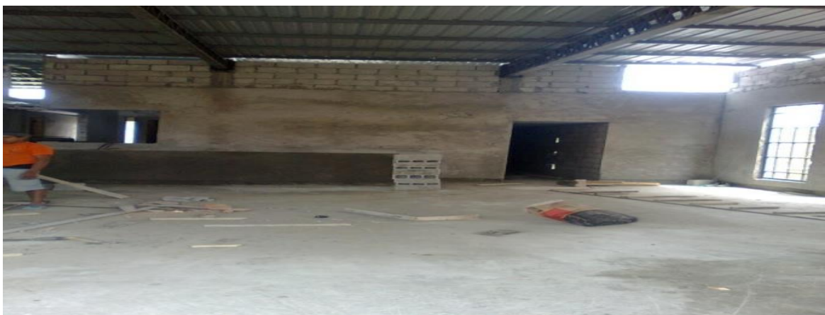
DESCRIPCIÓN: ÁREA DEL RESTAURANTE FRENTE AL BAR AMBIENTES (GRADA) FUENTE: BETTY LOOR
