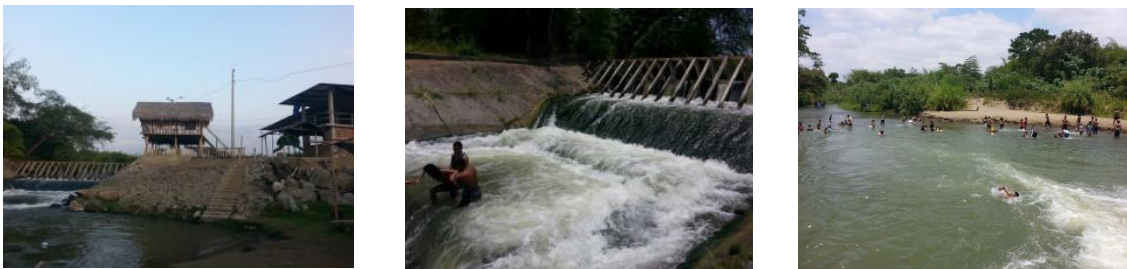
Figura 3.2. Balneario la Compuerta del Mocho Fotos: GAD Parroquial Calderón (2017)
