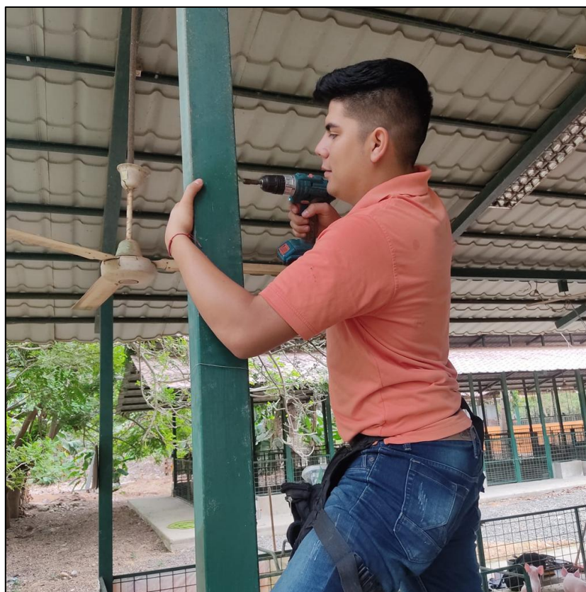
Ilustración 2. Instalación de la base para las cámaras
