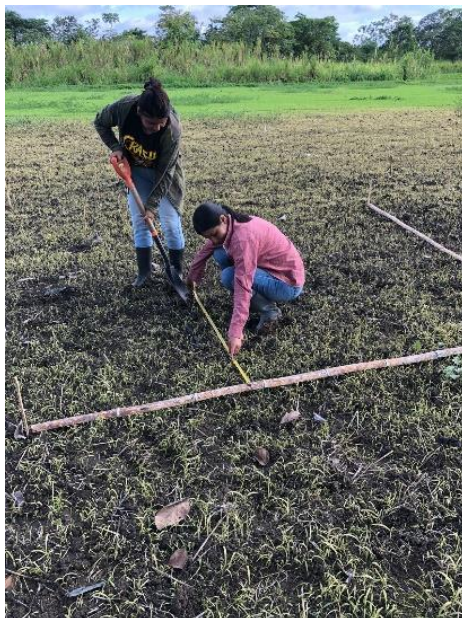
Anexo 9: Balizamiento del terreno
