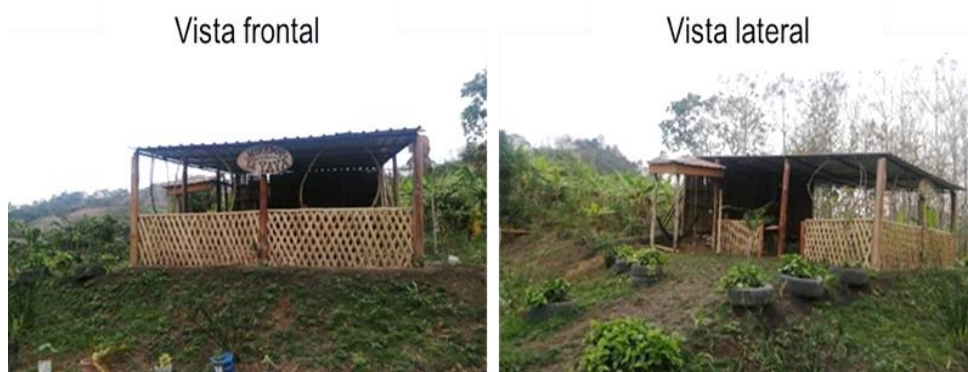
Figura 17. Construcción, bar restaurante.
