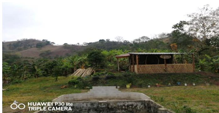
Figura 20. Piscina en proceso de impermeabilización.
