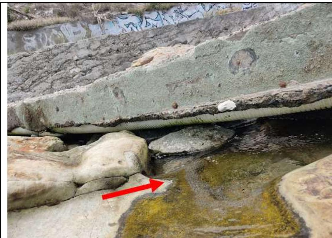
1-B: Descarga proveniente de la red de tuberías de la estación de bombeo Umiña.
