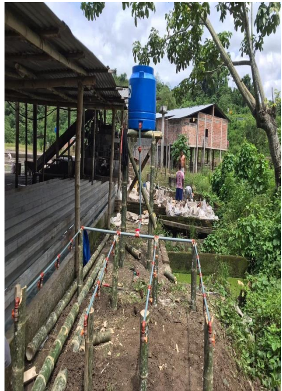
ANEXO 1.2 Construcción del sistema de abastecimiento.
