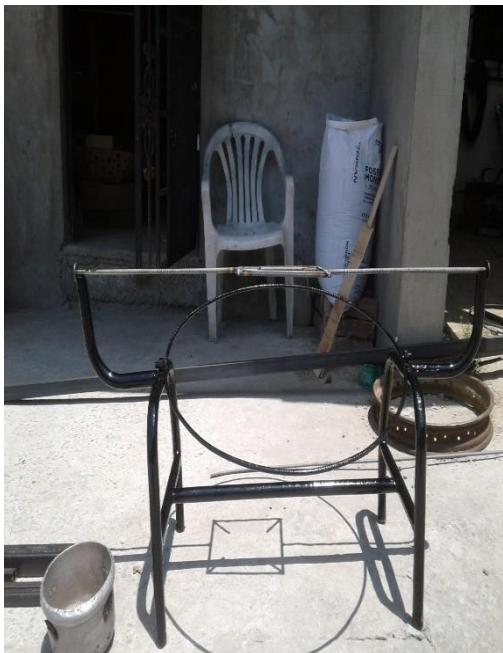
Anexo 3.13. Pintado final de la estructura
