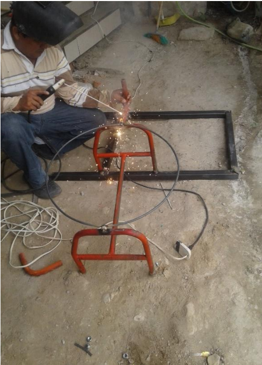
Anexo 3.11. Soldada de la estructura
