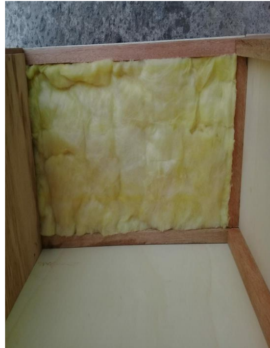
Anexo 3.6. Colocación de la lana de Vidrio
