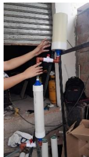
5. Ensamblando los filtros a la base
