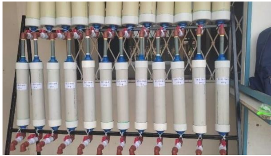
7. Ensamble a la base y rotulado los filtros
