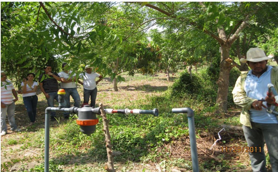
Foto 1 instalación del cabezal riego
