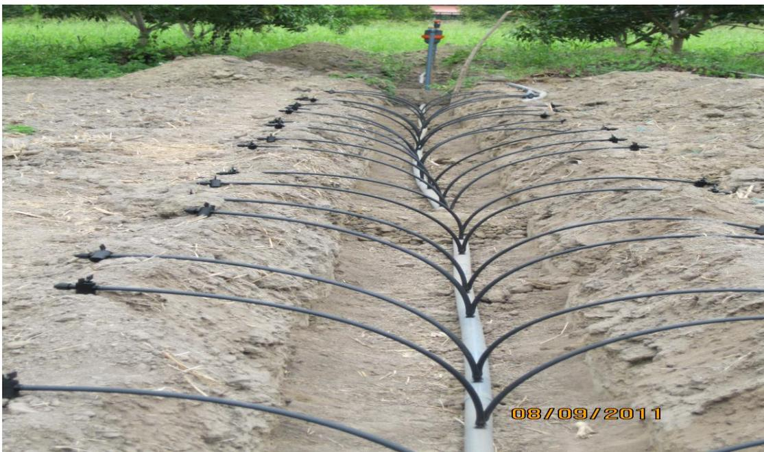
Foto 2: Sistema de riego instalación de chupones
